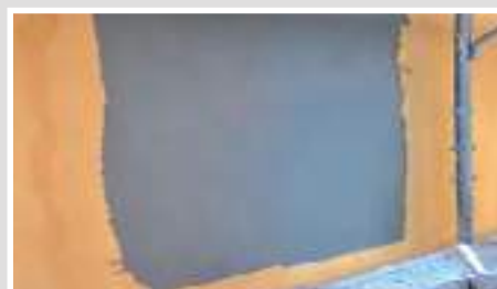
Parete pronta per applicazione della finitura
