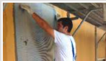
Stesura della rete di armatura
