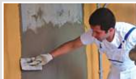
Annegamento della rete nel rasante
